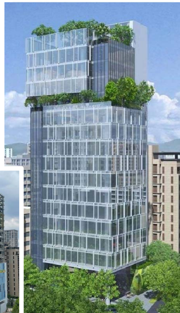
寶紘敦南商業大樓
